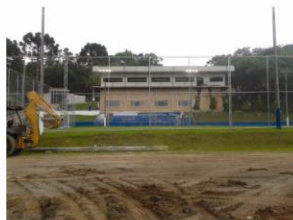
Vista do barracão com 300 m 2 .
